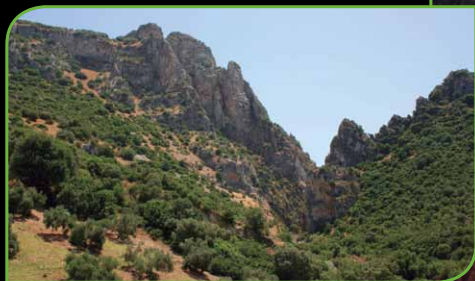
Panorámica del Peñón de Zaframagón desde el viaducto.
